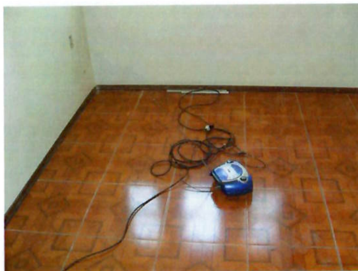
Figura 23 – Fios dispersos pela área de trabalho – risco de quedas e choques
