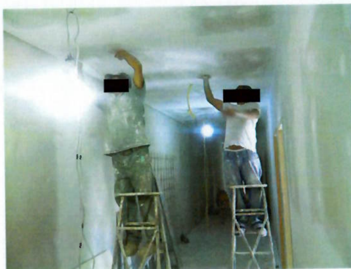
Figura 07 – Exposição a poeiras provenientes do processo de lixamento de massa corrida.
